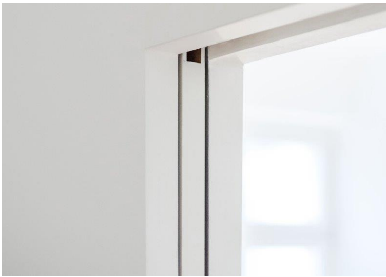
Wingburg_Belport_1: Dank der durchdachten Technik ist die Schiebetür oben in der Laufschiene eingehängt und gleitet innenliegend einfach in die Wandtasche.
